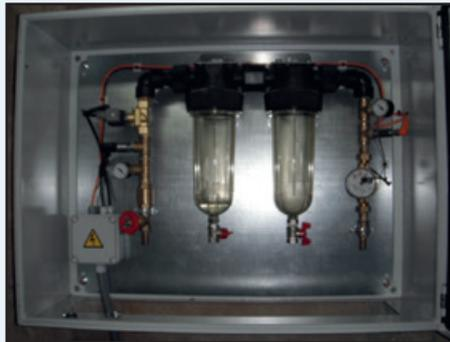
Ilustración 24. Módulo de control y sistema de filtrado.
