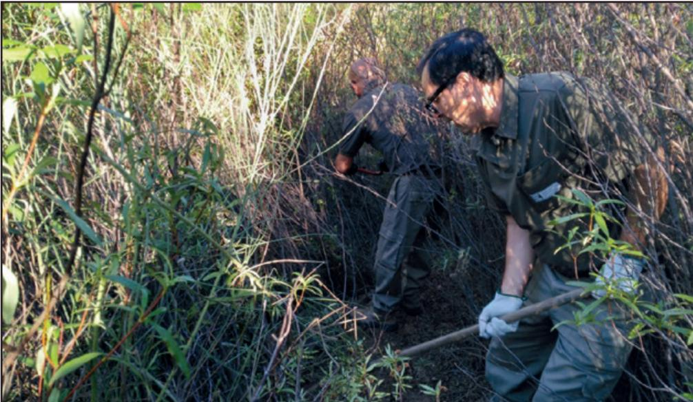
Ilustración 38. Apertura de accesos mediante eliminación de vegetación.
