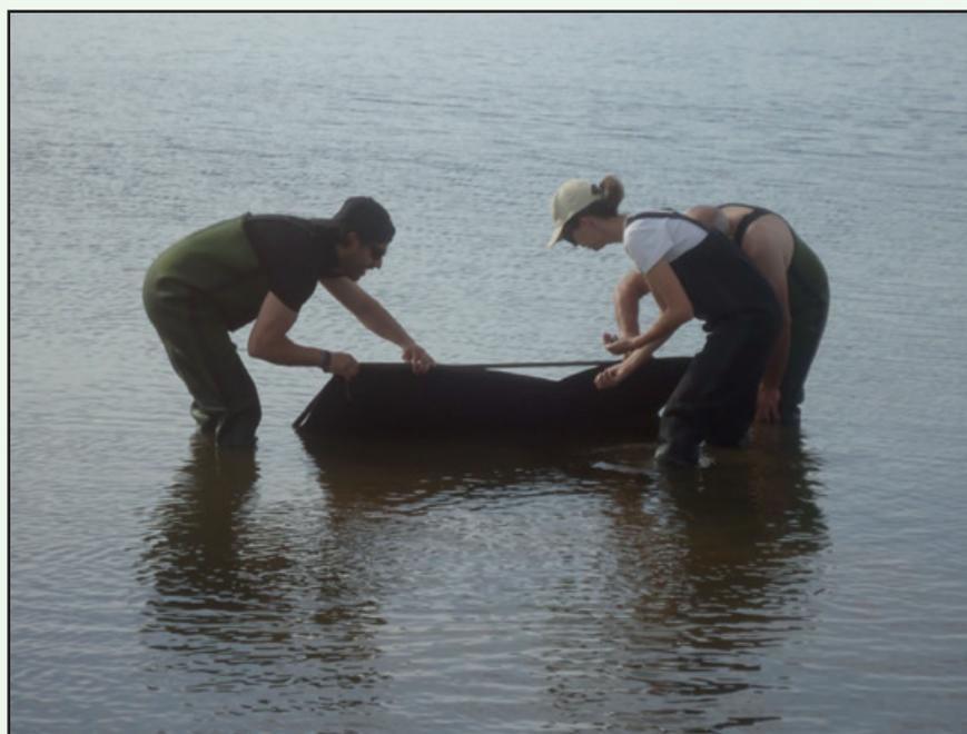
*Ilustración 25. Colocación de mantas bentónicas en el medio natural (Embalse del Boquerón).*
